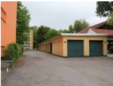
Gestaltungsdefizite Garagenhof an der Poststraße
