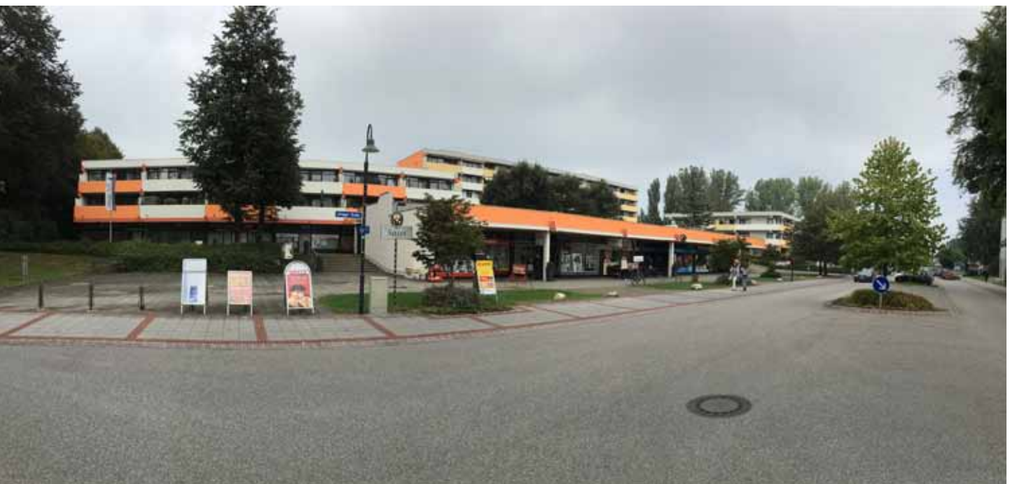
ingeschossiger Bau mit Gewerbenutzungen an der Allinger Straße
