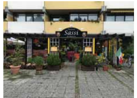
Gestaltung Alois-Harbeck-Platz - Außenraum Gastronomie wenig einladend - Gestaltung Platz: Belag, Bepflanzung
