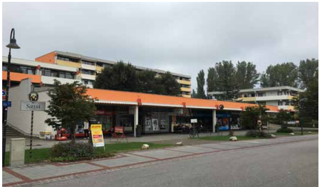
Ladenlokale mit Zugang sowohl von der Allinger Straße als auch vom Alois-Harbeck-Platz
