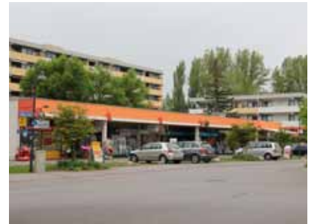
Potenzial bauliche Ergänzung - Abbruch und evtl Neubau
