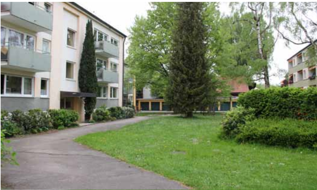
mangelhafte Gestaltung der Eingangsbereiche
