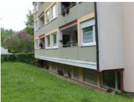
Souterrain - nicht ausreichende Belichtung - Gewerbeeinheiten im Kelergeschoss
